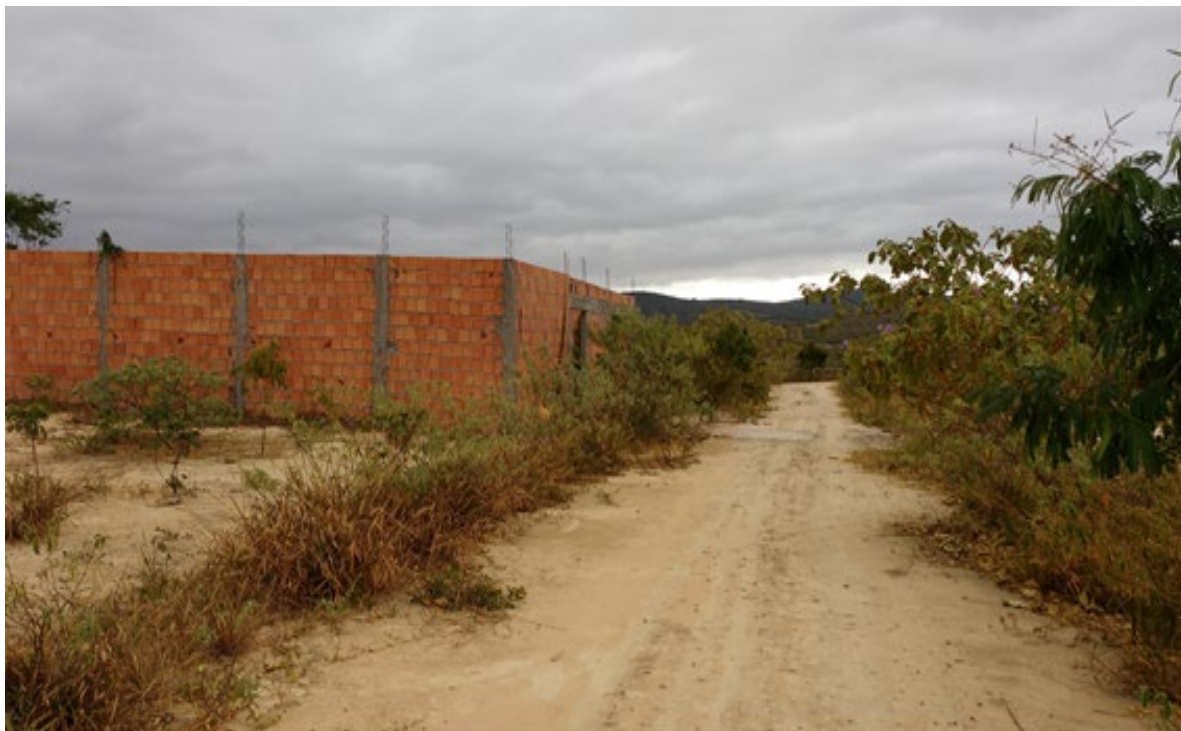
Figura 1 - casa em construção em loteamento abandonado
