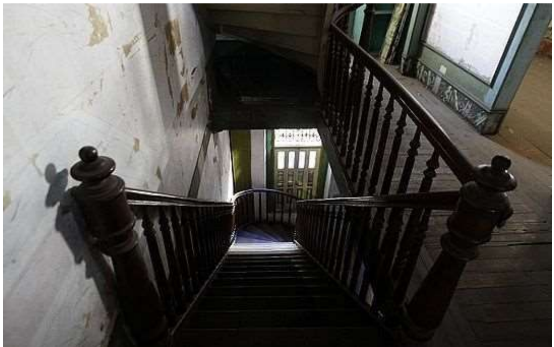
Imagens 02, 03 e 04. Fotografias internas do casarão. Pode-se notar os acabamentos rebuscados nas paredes e forro, o piso e corrimão originais em madeira. Fonte: Correio 24horas.
