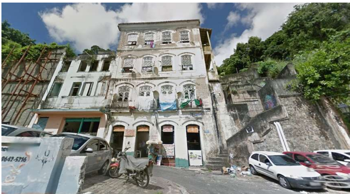
Imagem 07. Fachada do Sobrado nº56 na ladeira do Taboão. Fonte: SIPAC.
