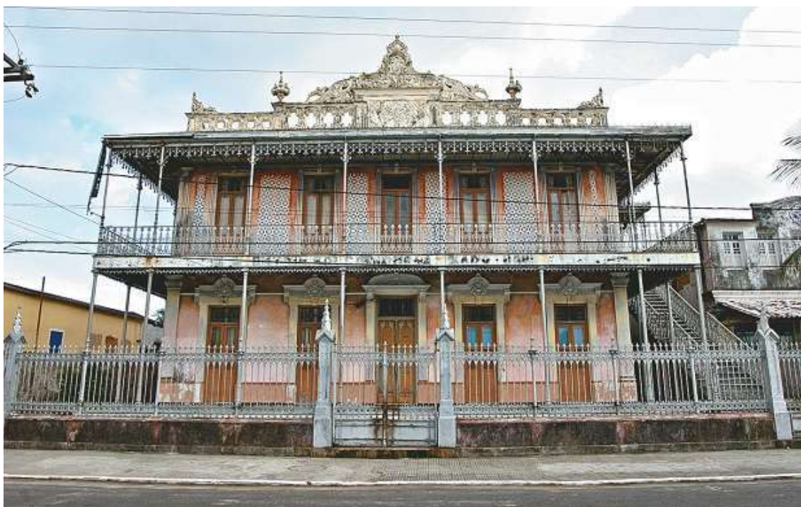
Imagem 01. Fachada do Solar Amado Bahia. Fonte: G1 Bahia.
